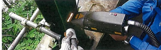
最新のクリーンレーザーシステムを使用するクリーンレーザー工法は、高出力のレーザー光線が旧塗膜・鉄サビ部分を瞬時に除去し、微粒子を吸引するため、粉じんの飛散や産業廃棄物の発生・ケレン作業中の騒音などが抑えられ、作業環境の改善にも繋がり、現場作業員の負担を大幅に軽減するメリットが期待出来ます。
