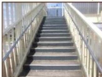
横断歩道橋蹴上り(補修後)
