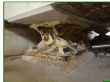
支承再塗装(補修前)
