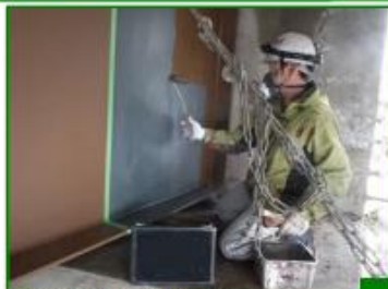
橋梁桁端部(補修中)
