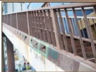
横断歩道橋外面(補修前)
