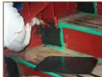
横断歩道橋蹴上り(補修中)
