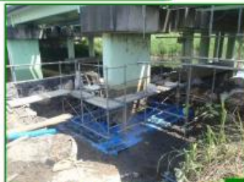
ハイルベント杭喫水線防食(補修中)
