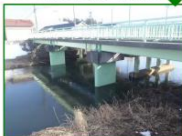
ハイルベント杭喫水線防食(補修後)
