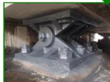
支承再塗装(下塗り施工後)
