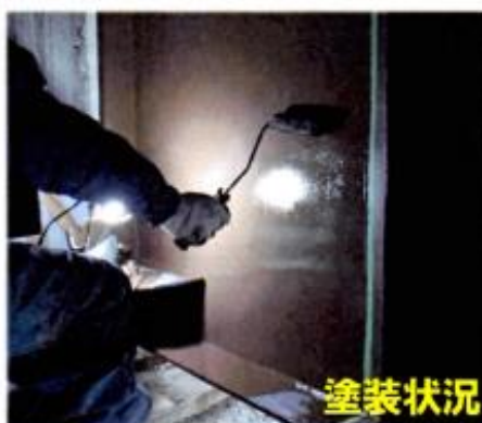
桁端部の再塗装
