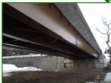
橋梁桁端部(補修後)
