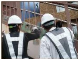
横断歩道橋外面(補修中)
