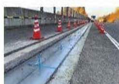
流水部設置完了
