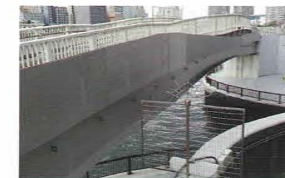
橋桁にも採用された素材です
