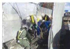
②背面(歩道)コンクリート研り
