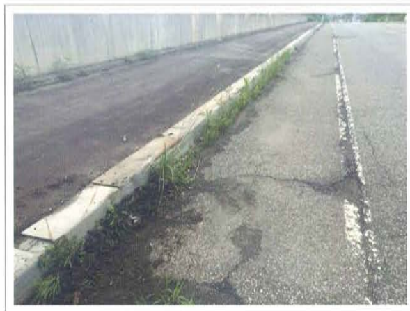
更新前の鋼製排水溝(SS400+溶融亜鉛メッキ製品)
