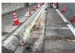
既設材撤去後の床版状況
