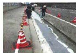
③橋面防水
