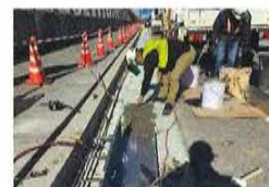
④敷モルタル
