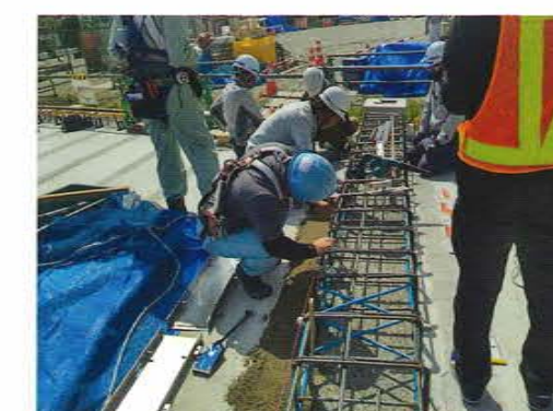
施工現場立会い
