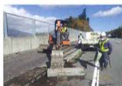
①既設材撤去
