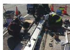
⑥流水部固定(溶接)
